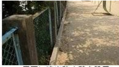
周囲に流出防止壁を設置
