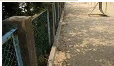
周囲に流出防止壁を設置
