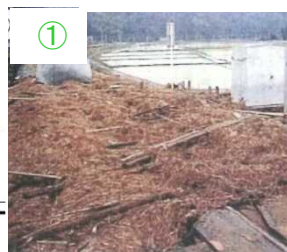
H16.10被災状況
