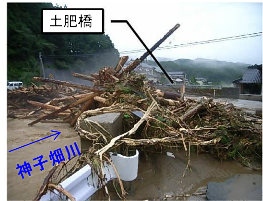
平成21年8月の台風第9号による被害状況
