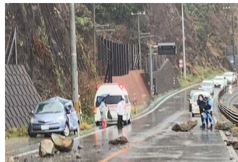
既存施設を越える落石の発生 (R3.11 新温泉町)
