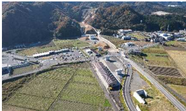
山陰近畿自動車道 浜坂道路 期 新温泉浜坂 IC(新温泉町)
