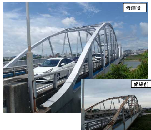
県道白浜姫路停車場線 阿保橋 (姫路市) [橋梁修繕]
