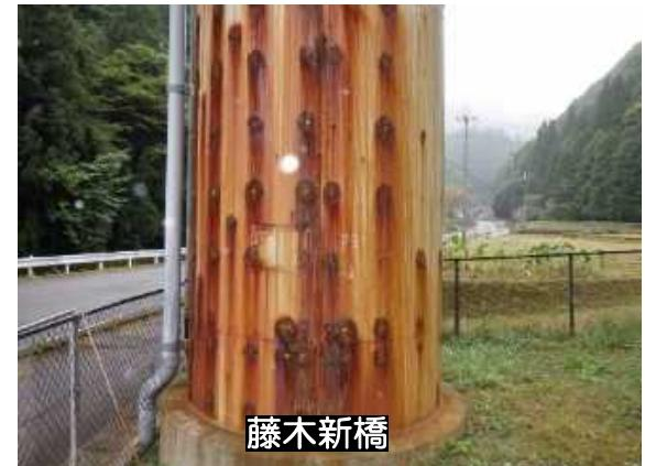
【橋脚巻立て鋼板の腐食】
