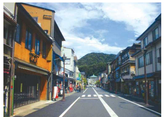
図 2.4 無電柱化による良好な景観形成 (整備事例：豊岡市 城崎温泉街)
