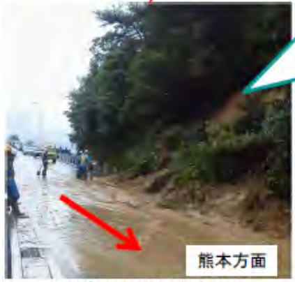
▲災害発生(法面崩壊)状況 【国道266号(国道324号)】 (上天草市松島町合津)
