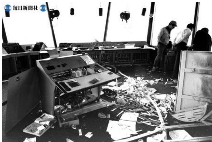
管制卓の破壊
