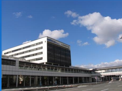
伊丹ターミナルビル
