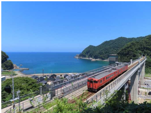
余部鉄橋「空の駅」
