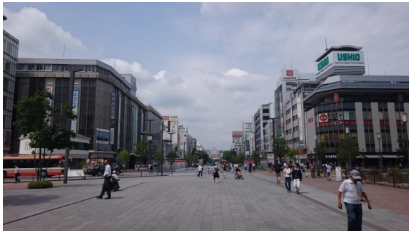
図 4-48 JR 姫路駅周辺バリアフリー化の状況（歩行者優先の道路整備）
