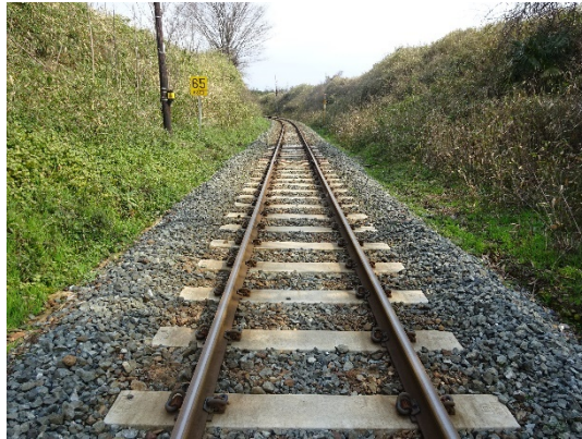
図 4-58 PC マクラギへの交換（京都丹後鉄道）
