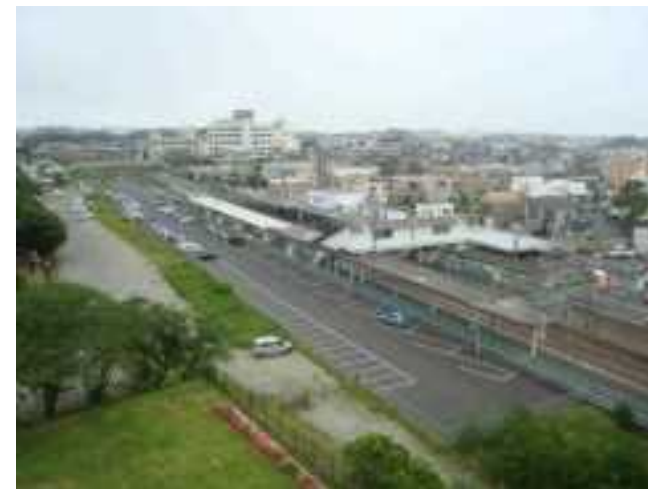
[工事着手前の大甕駅西側]
