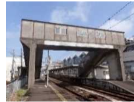
既存施設の 撤去
