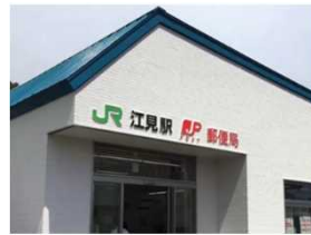
駅舎の 新改築・移設
