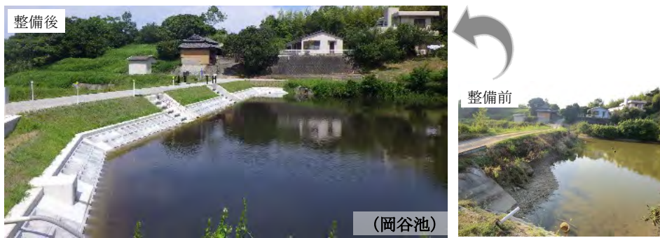
決壊リスクに備えるため池改修
