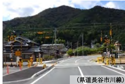
歩行者の安全確保を図るための踏切の拡幅
