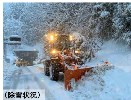
日常の維持管理(道路除雪)
