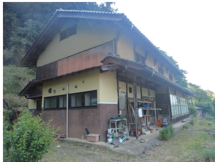
③保全対象(人家)
