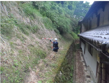
②保全対象とがけの状況
