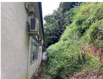
②保全対象とがけの状況
