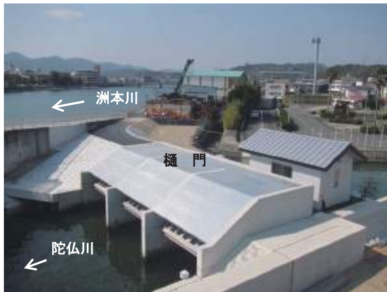
写真6.6 陀仏川樋門（整備後）
