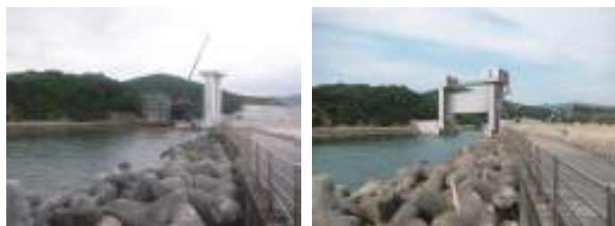
写真6.3 本庄川水門(工事中) 図6.4 本庄川水門整備イメージ
