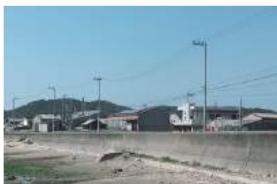
写真6.4 防潮堤(着工前)
