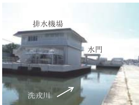
写真6.9 洗戎川排水機場・水門（完成）
