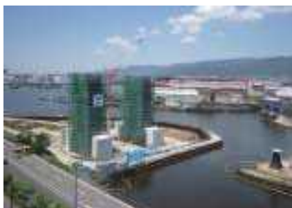
写真5.14 新川水門（工事中）
