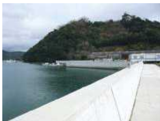
写真5.1 防潮堤整備（福良港）
