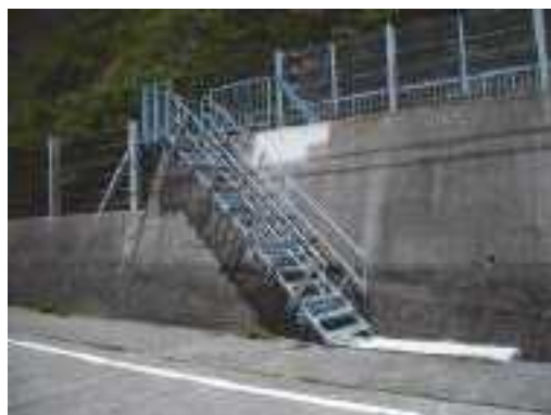
写真5.5 緊急避難用階段(洲本灘賀集線(洲本市))
