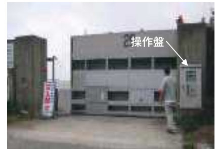
写真5.4 陸閘の電動化（尼崎西宮芦屋港）
