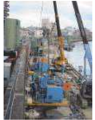
写真5.12 地盤改良工法の例 (左：薬液注入工法 右：高圧噴射攪拌工法)
