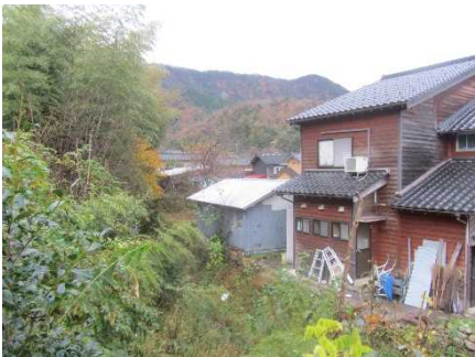
②保全対象とがけの状況
