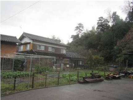
③保全対象(人家)
