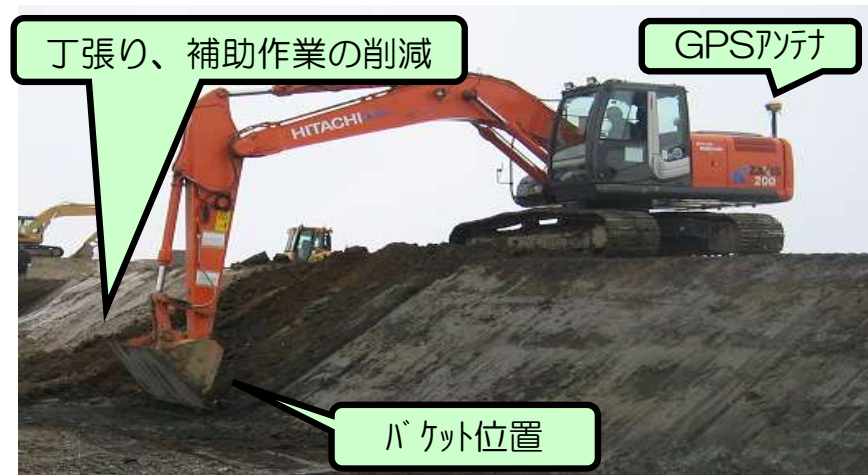
河川堤防の盛土工事
