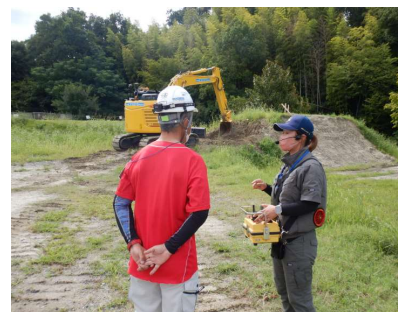
目の前で建機を見ながら遠隔操作
