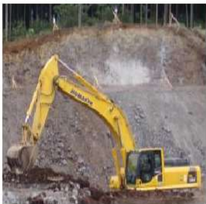
屋外での作業、一品生産
