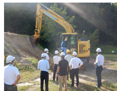
ICT建機(MCバックホウ)の操作
