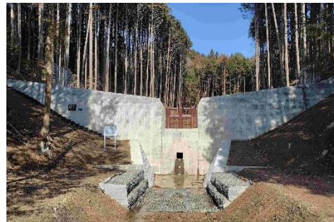
下母子谷川 砂防堰堤 (三田市)
