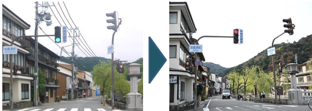
県道 豊岡竹野線 I 工区(豊岡市)
