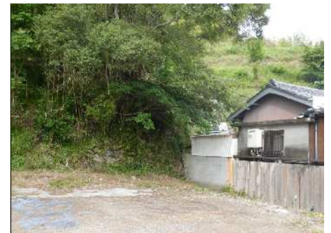
④荒廃状況
