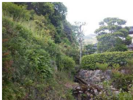
③保全対象とがけの状況
