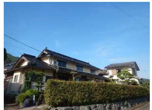
④保全対象(人家)
