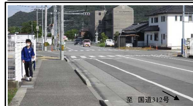
② 完成区間 (歩行者の安全を確保)
