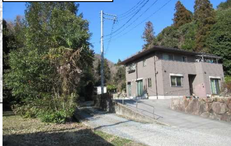
保全対象人家
