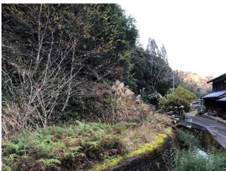
②保全対象とがけの状況
