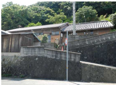
③保全対象(人家)
