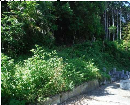
②斜面状況
