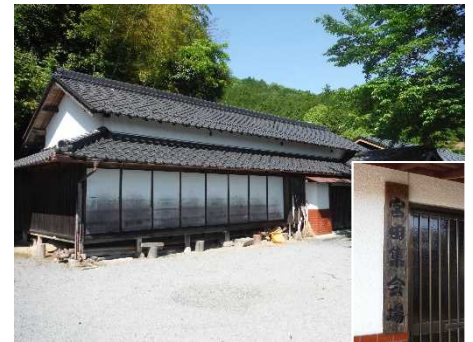
④保全対象(避難所)宮田集会所
