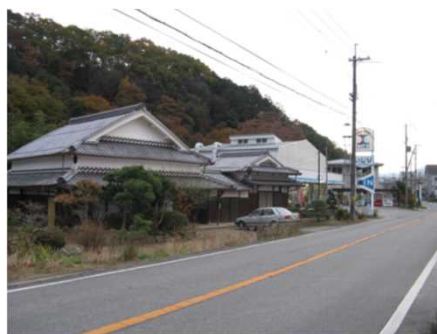
③保全対象(人家)
