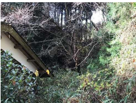
② 保全対象とがけの状況
