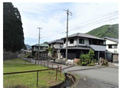
④ 保全対象(人家)
