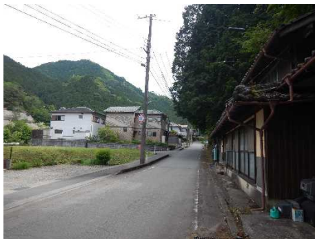
③ 保全対象(人家)
