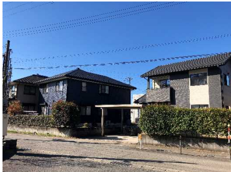
④保全対象(人家)
