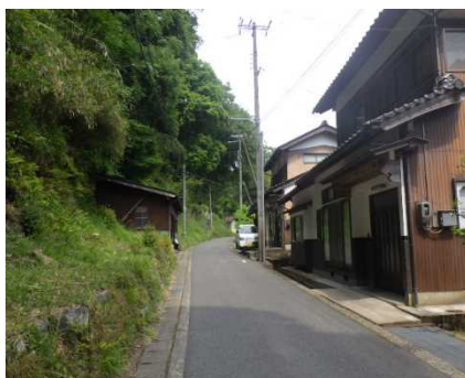
③保全対象(人家)
