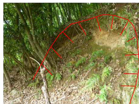
④ 荒廃状況
