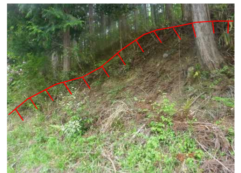
④ 荒廃状況
