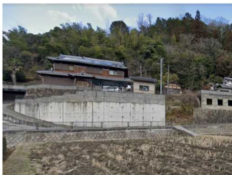
③保全対象(人家)
