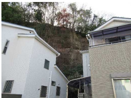
② 保全対象とがけの状況
