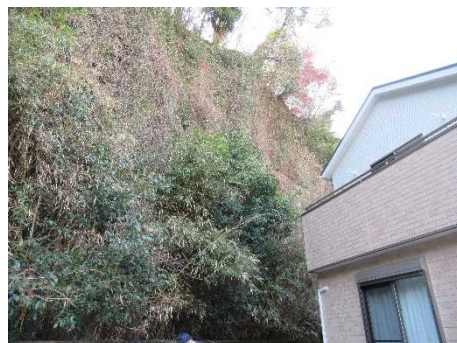
③ 保全対象とがけの状況
