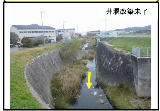
④ 残事業区間 (下流井堰付近)
