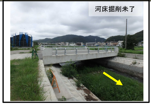
② 暫定完成区間 (片山中村橋付近)
