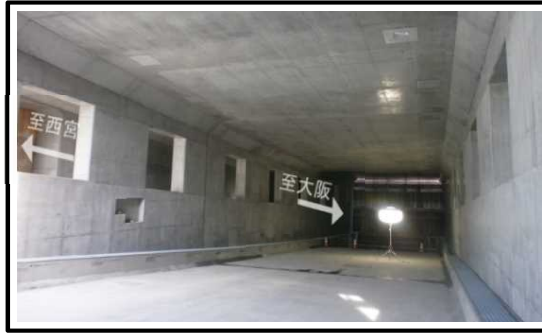
②工事の進捗状況(JRアンダーパス部)
