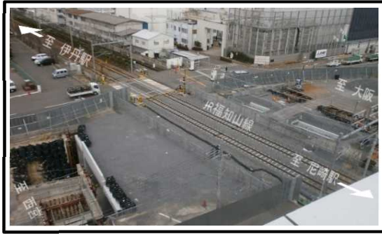
①工事の進捗状況(JRアンダーパス部)
