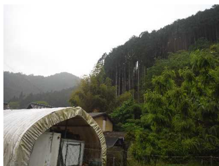
③保全対象とがけの状況
