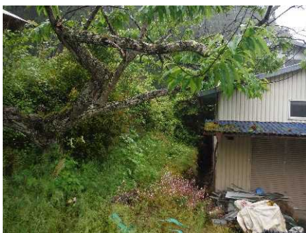
②斜面状況(人家裏)
