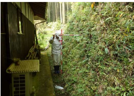
②斜面状況(人家裏)
