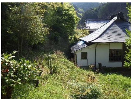
②斜面状況(人家裏)
