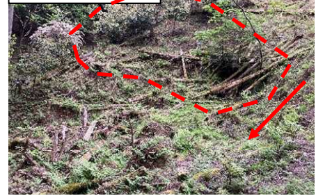
溪流荒廃状況
