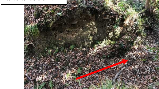
溪流荒廃状況
