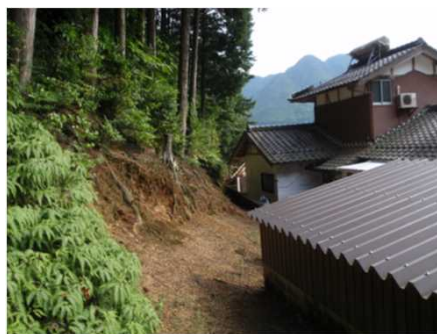
③保全対象とがけの状況
