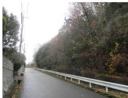
③保全対象とがけの状況
