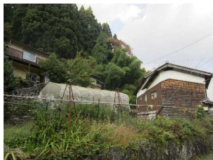
③保全対象とがけの状況
