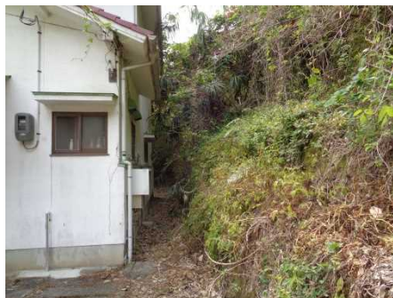
③保全対象とがけの状況
