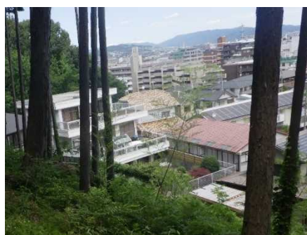
③保全対象とがけの状況
