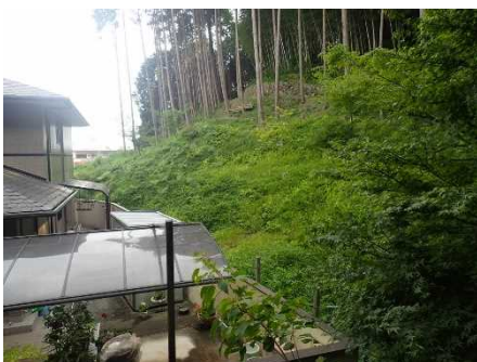
②保全対象とがけの状況
