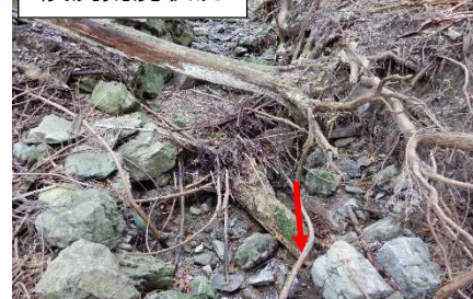
溪流荒廃状況
